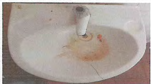
Foto10: Sustitucion de lavamanos
