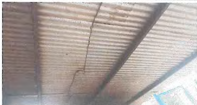
Foto1: Sustitucion de lamina
