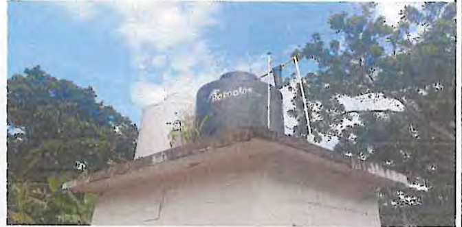
Foto 14: Sustitucion de accesorios para deposito de agua
