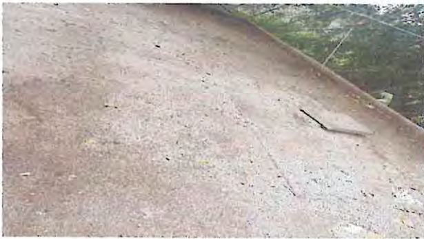
Foto 15: Red de drenaje y tuberías de agua potable
