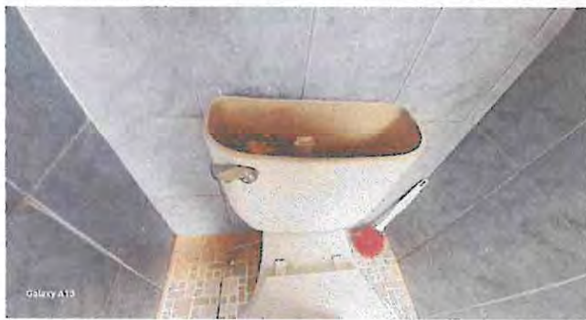
Foto 9: Sustitucion de sanitario y accesorios
