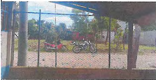
Foto7: Reparación de muro perimetral
