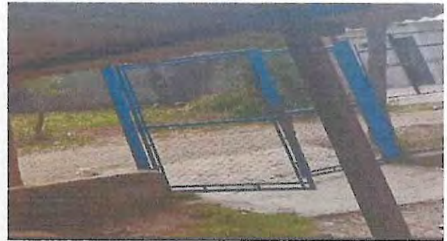
Foto 8: Reparacion de Porton de metal
