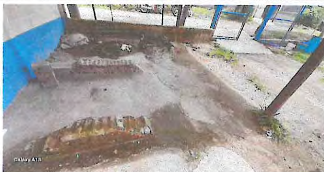
Foto 3: Reparacion Piso de concreto
