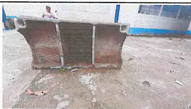
Foto 6: Sustitución de pilas
