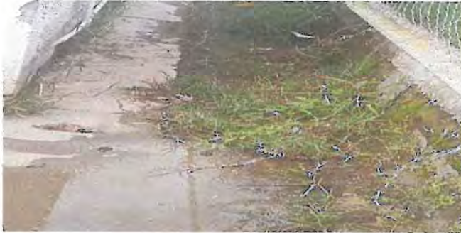
Foto 13: Red de drenaje y agua potable
