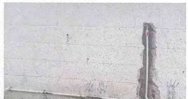
12: Sustitución de tuberías PVC
