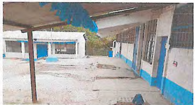
Foto 16: Pintura de muros exteriores e interiores
